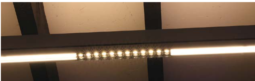
L'étonnant rail K-Scape propose éclairage Led et sonorisation en un seul produit grâce à l'intégration de mini haut-parleurs.
